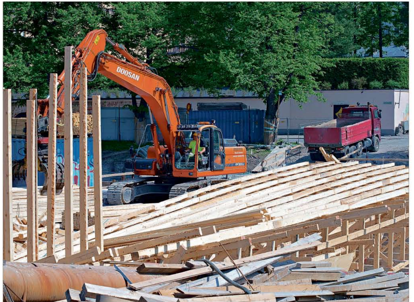
Ny fas. Träformen som täcker bron tas bort efter gjutningen som sker i mitten av juli. Foto: Stefan Crämer
